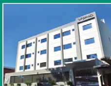
Edificio Corporativo Asismed
