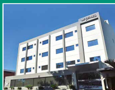
Edificio Corporativo Asismed
