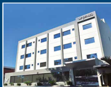
Edificio Corporativo Asimed
