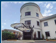
Centro Integral de Rehabilitación Asunción (CIRA)
