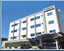
Edificio Corporativo Asimed
