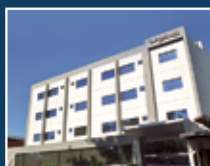
Edificio Corporativo Asismed
