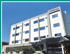
Edificio Corporativo Asismed
