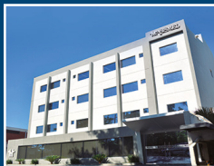
Edificio Corporativo Asismed
