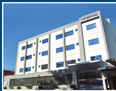
Edificio Corporativo Asismed
