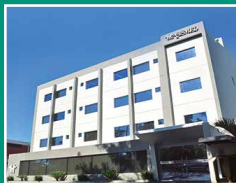
Edificio Corporativo Asismed
